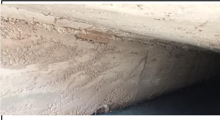
KONDISI BANGUNAN BAWAH
