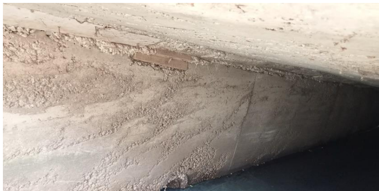
KONDISI BANGUNAN BAWAH
