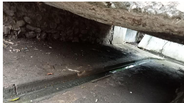
KONDISI BANGUNAN BAWAH
