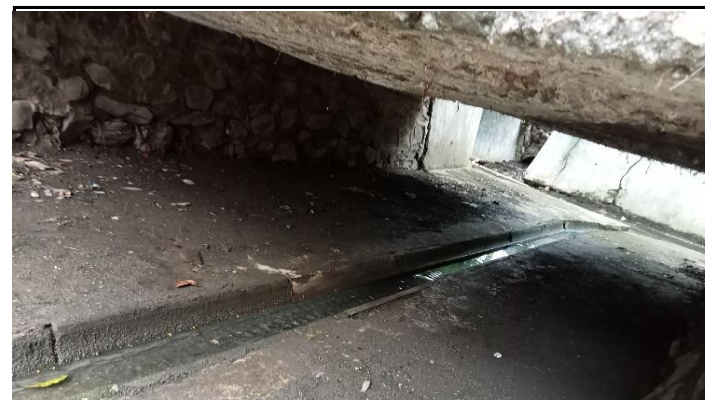
KONDISI BANGUNAN BAWAH
