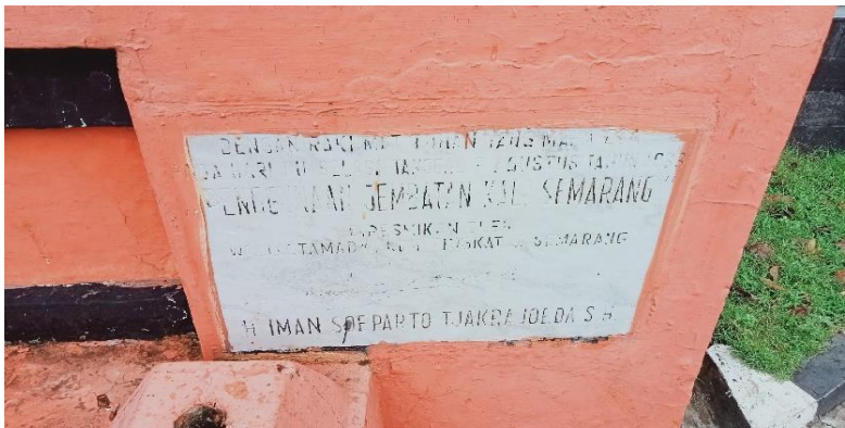
PAPAN NAMA JEMBATAN
