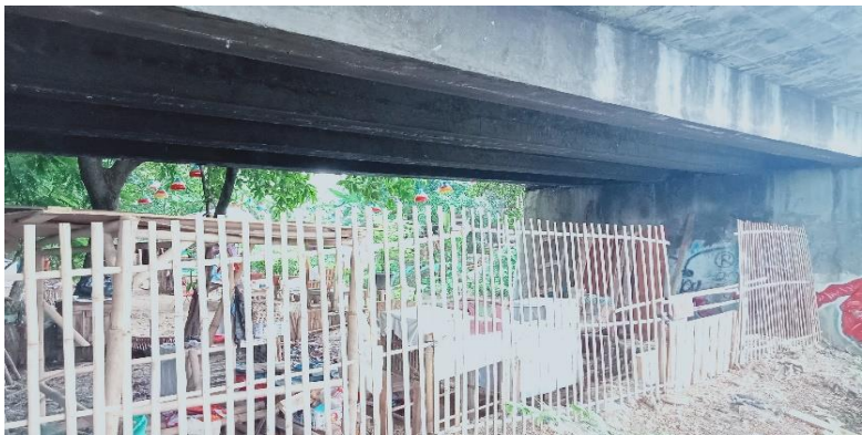
KONDISI BANGUNAN BAWAH
