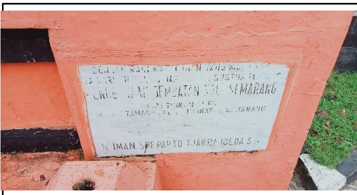
PAPAN NAMA JEMBATAN
