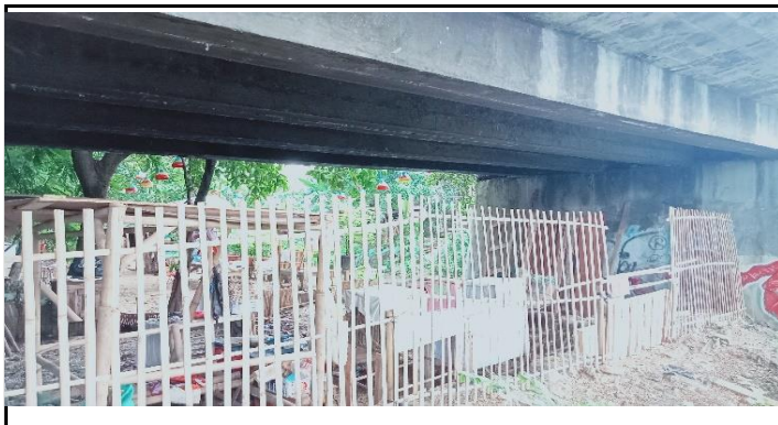
KONDISI BANGUNAN BAWAH
