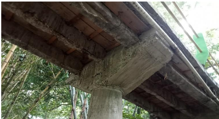
KONDISI BANGUNAN BAWAH
