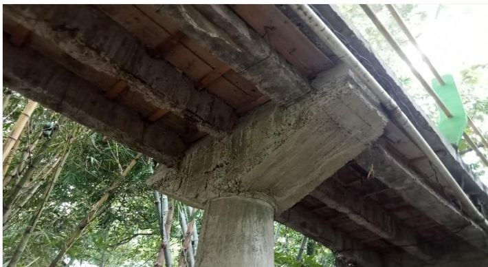
KONDISI BANGUNAN BAWAH
