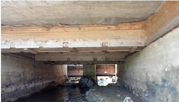
KONDISI BANGUNAN BAWAH
