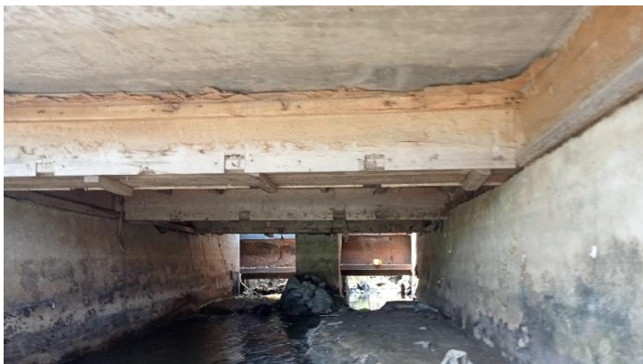
KONDISI BANGUNAN BAWAH
