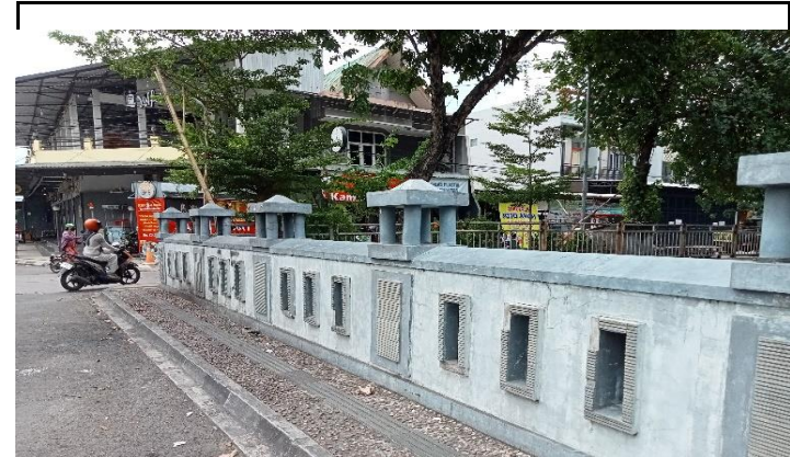
KONDISI SANDARAN DAN TROTOAR
