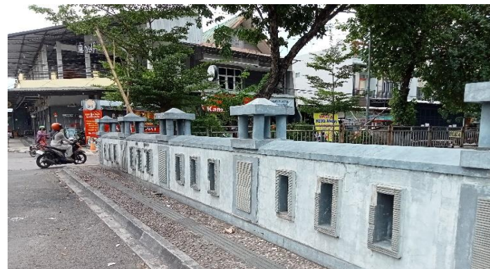
KONDISI SANDARAN DAN TROTOAR
