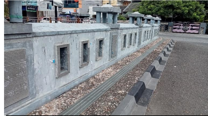
KONDISI SANDARAN DAN TROTOAR
