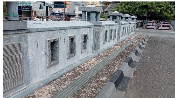
KONDISI SANDARAN DAN TROTOAR
