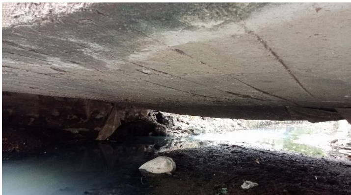
KONDISI BANGUNAN BAWAH
