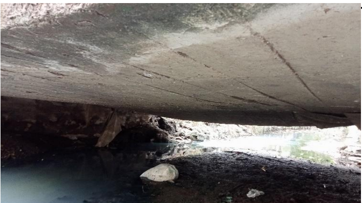
KONDISI BANGUNAN BAWAH
