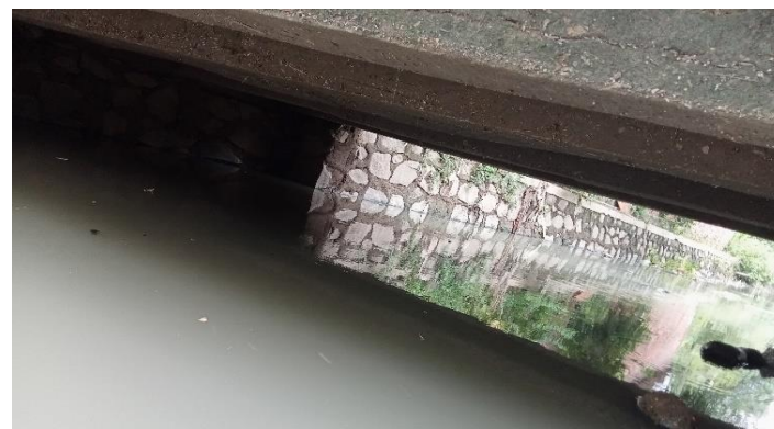
KONDISI BANGUNAN BAWAH
