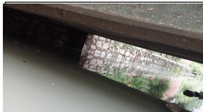
KONDISI BANGUNAN BAWAH
