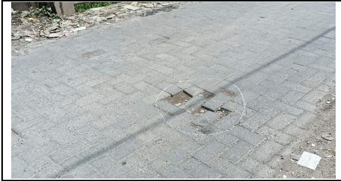
LAPISAN PERMUKAAN LANTAI BERLUBANG
