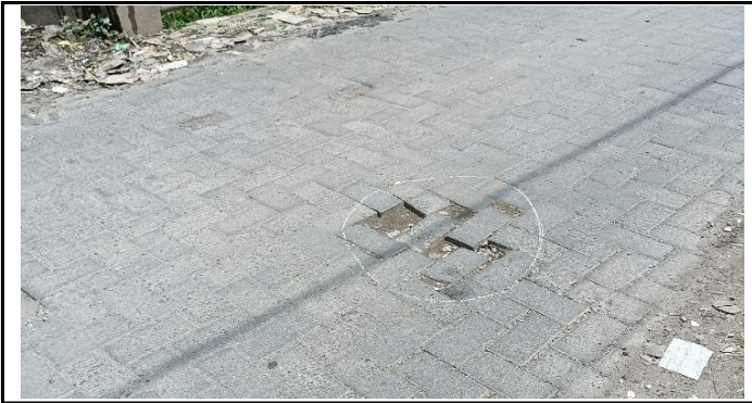
LAPISAN PERMUKAAN LANTAI BERLUBANG
