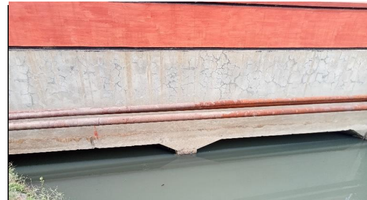
KONDISI BANGUNAN BAWAH
