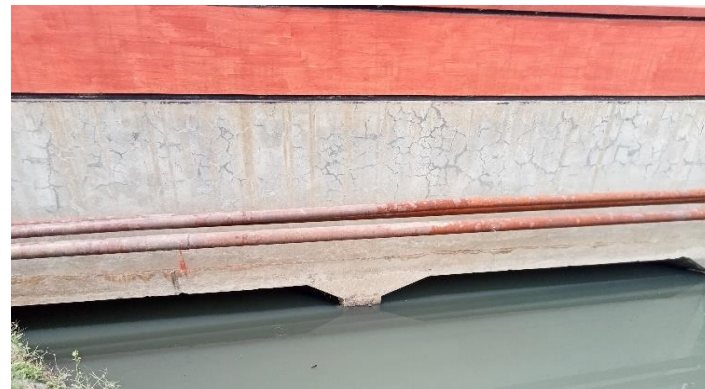
KONDISI BANGUNAN BAWAH
