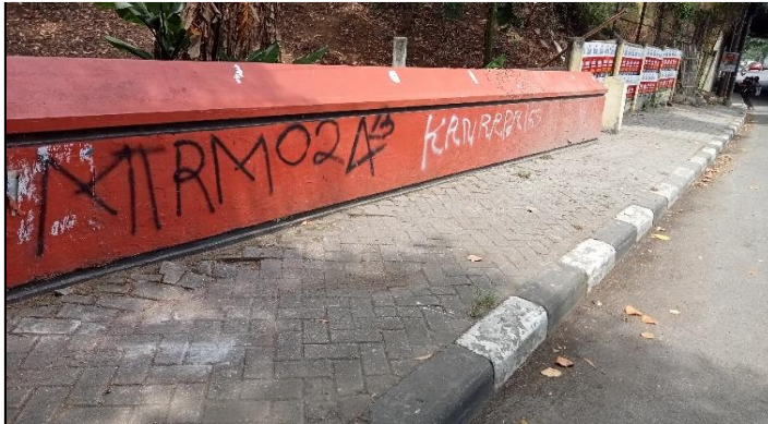
KONDISI SANDARAN DAN TROTOAR
