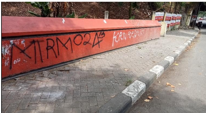
KONDISI SANDARAN DAN TROTOAR
