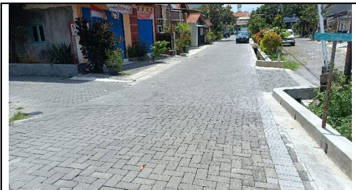
KONDISI JALAN PENDEKAT
