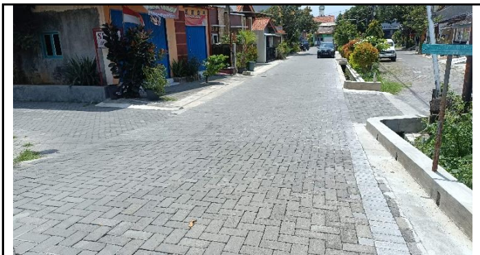
KONDISI JALAN PENDEKAT
