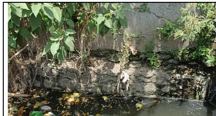
KONDISI TEBING SUNGAI
