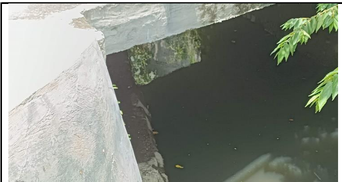
KONDISI KEPALA JEMBATAN
