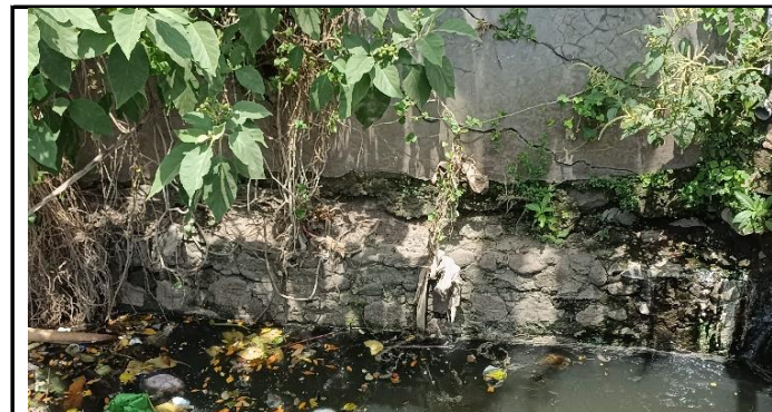
KONDISI TEBING SUNGAI
