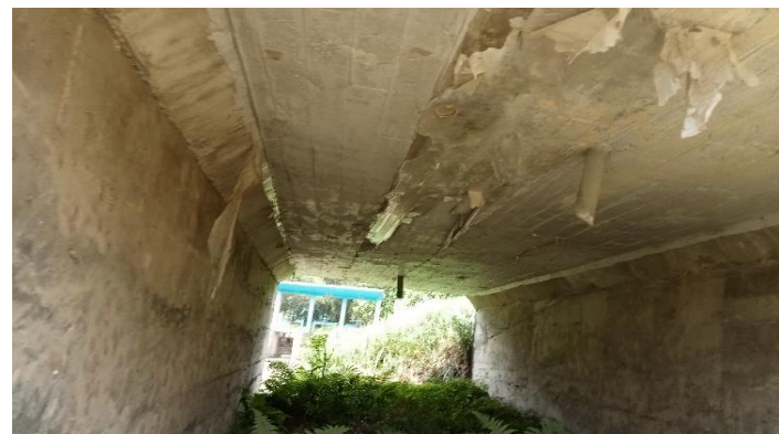
KONDISI BANGUNAN BAWAH
