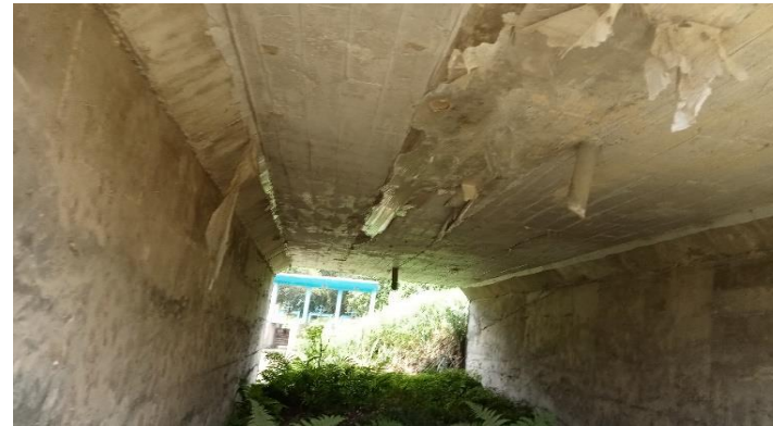
KONDISI BANGUNAN BAWAH
