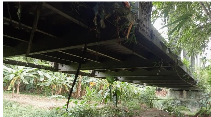
KONDISI BANGUNAN BAWAH
