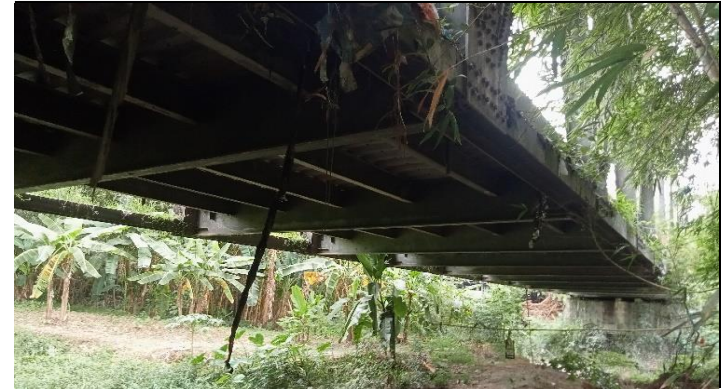
KONDISI BANGUNAN BAWAH
