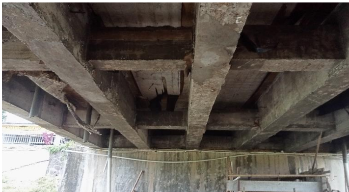
KONDISI BANGUNAN BAWAH
