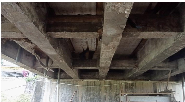
KONDISI BANGUNAN BAWAH
