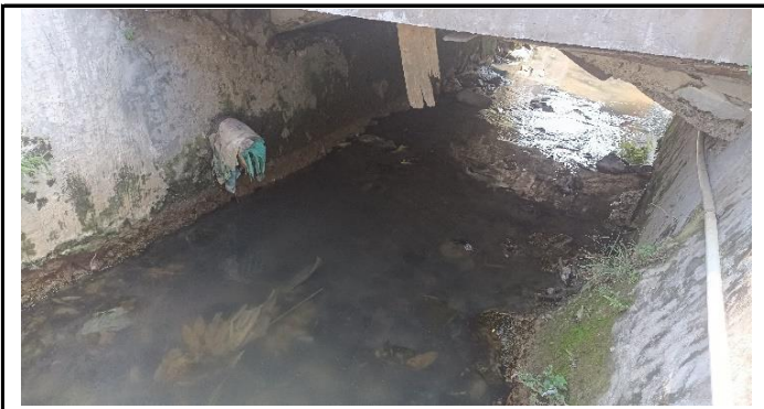
KONDISI BANGUNAN BAWAH
