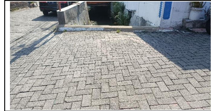
KONDISI LAPISAN PERMUKAAN LANTAI
