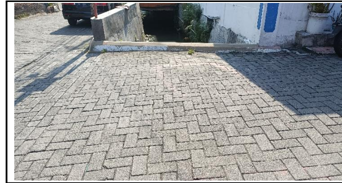
KONDISI LAPISAN PERMUKAAN LANTAI
