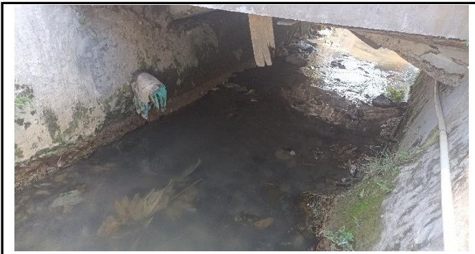
KONDISI BANGUNAN BAWAH
