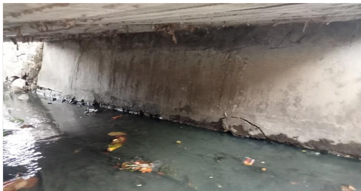
KONDISI BANGUNAN BAWAH
