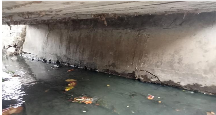
KONDISI BANGUNAN BAWAH
