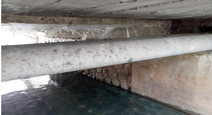
KONDISI BANGUNAN BAWAH
