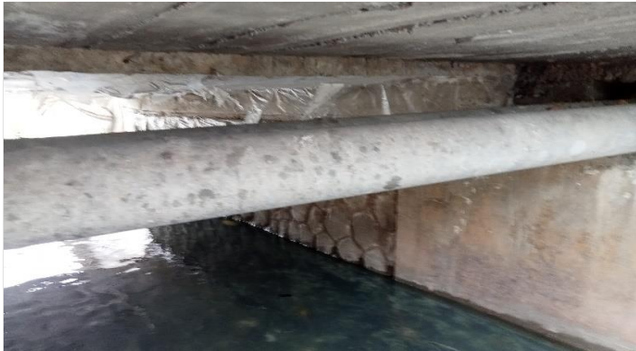
KONDISI BANGUNAN BAWAH
