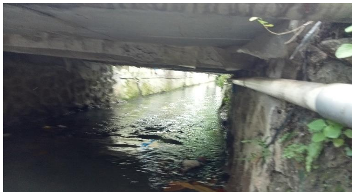
KONDISI BANGUNAN BAWAH
