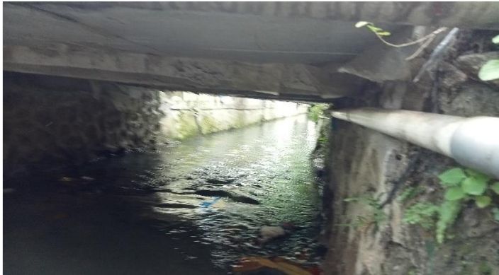
KONDISI BANGUNAN BAWAH
