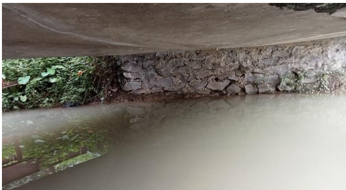
KONDISI BANGUNAN BAWAH
