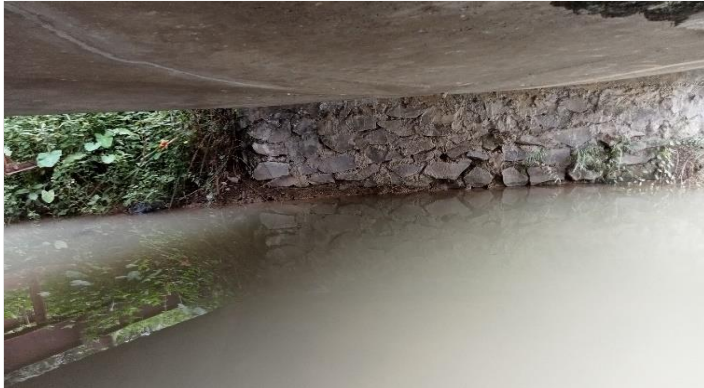
KONDISI BANGUNAN BAWAH
