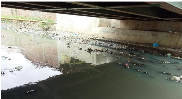
KONDISI BANGUNAN BAWAH
