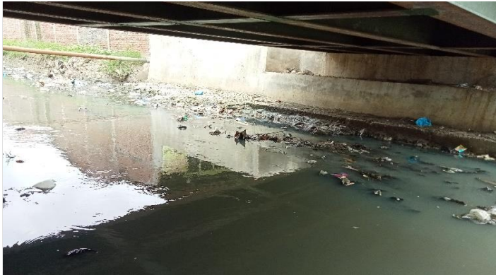
KONDISI BANGUNAN BAWAH
