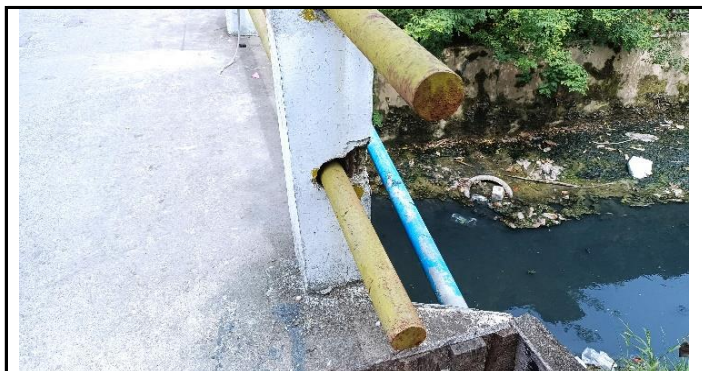
KONDISI BANGUNAN BAWAH
