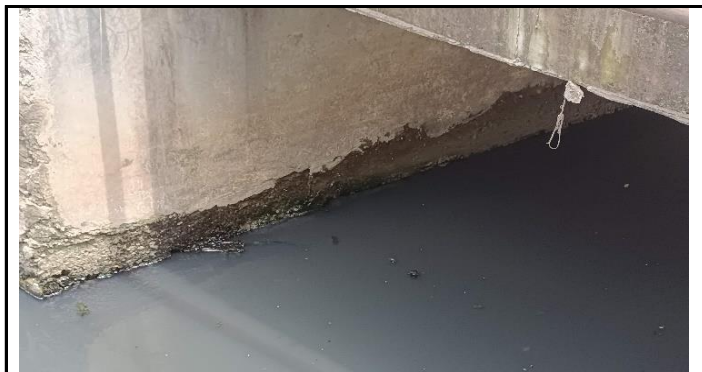
KONDISI JALAN PENDEKAT
