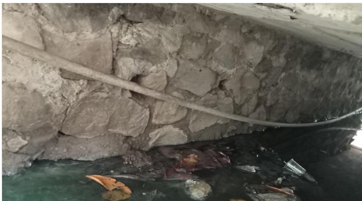
KONDISI BANGUNAN BAWAH
