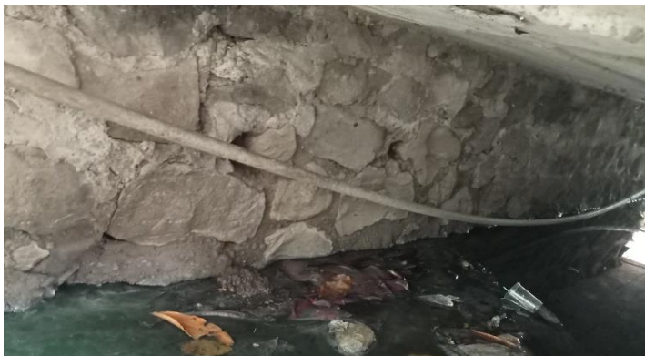
KONDISI BANGUNAN BAWAH
