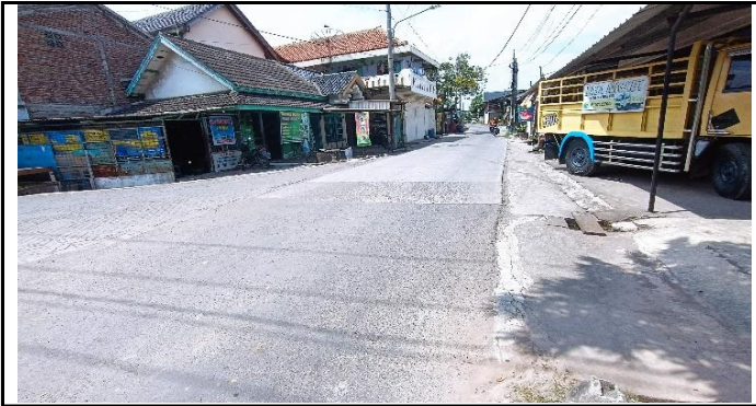
KONDISI JALAN PENDEKAT
