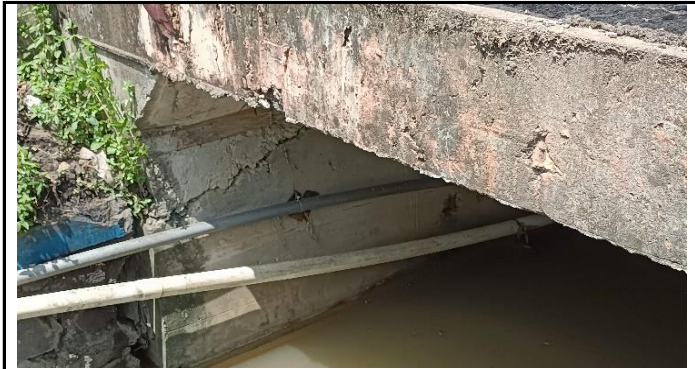
KONDISI BANGUNAN BAWAH
