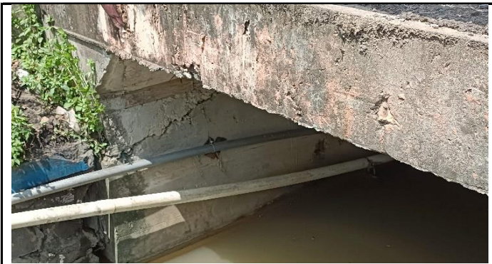
KONDISI BANGUNAN BAWAH
