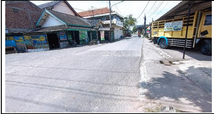
KONDISI JALAN PENDEKAT
