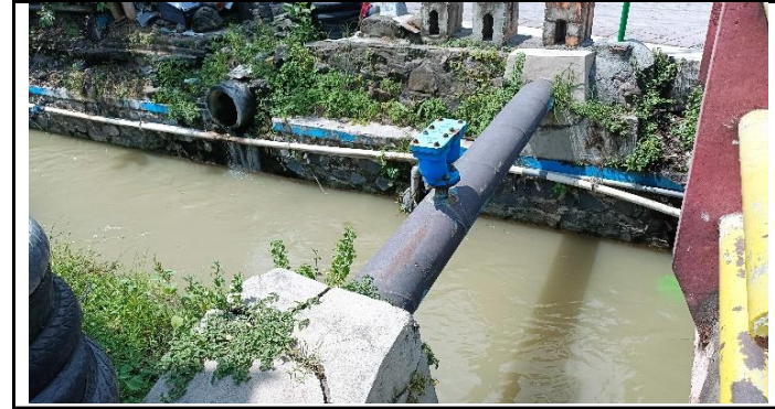
KONDISI PIPA UTILITAS AIR MINUM
