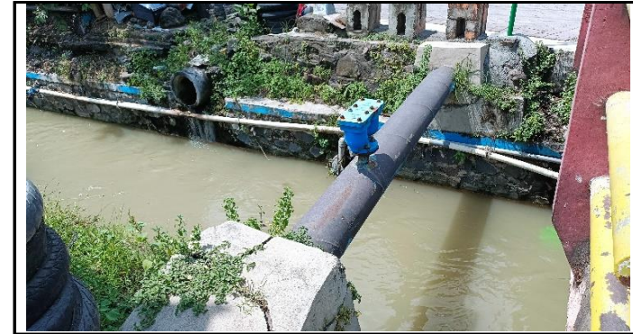
KONDISI PIPA UTILITAS AIR MINUM
