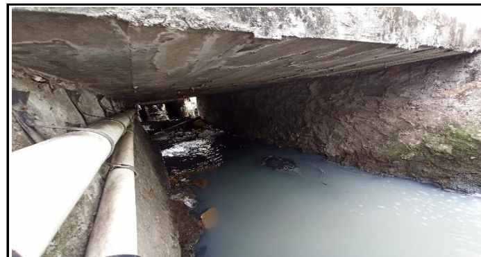
KONDISI BANGUNAN BAWAH
