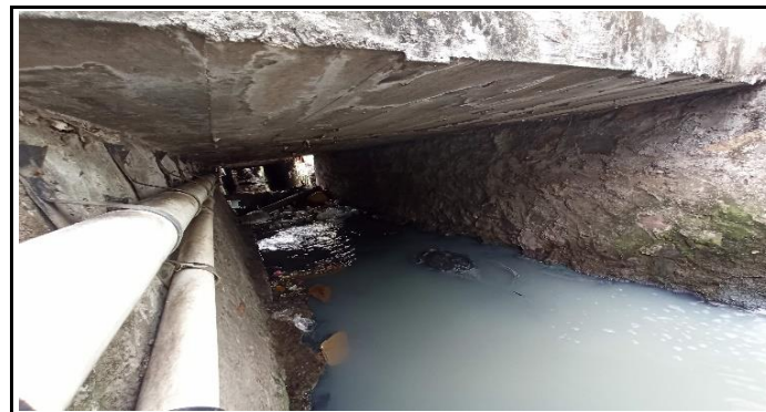
KONDISI BANGUNAN BAWAH
