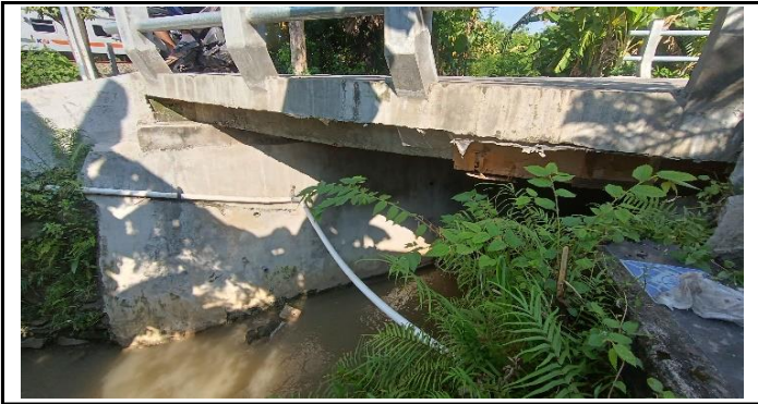
KONDISI GELAGAR JEMBATAN
