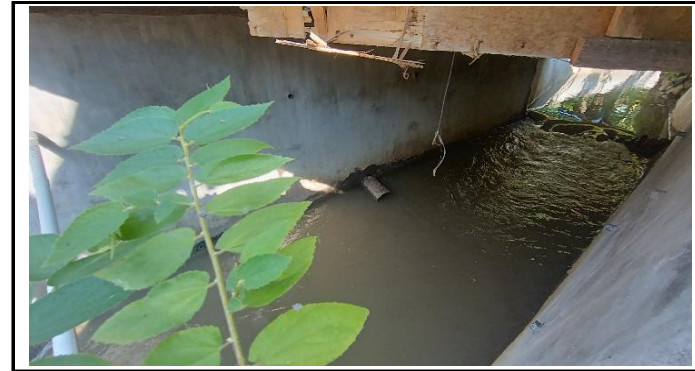
KONDISI BANGUNAN BAWAH
