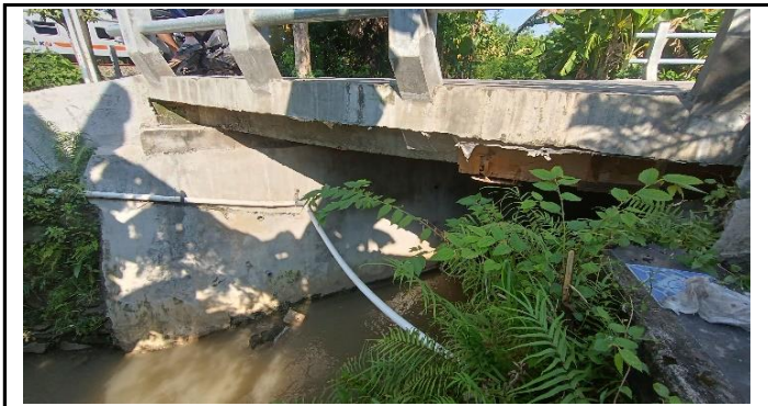
KONDISI GELAGAR JEMBATAN
