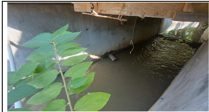
KONDISI BANGUNAN BAWAH
