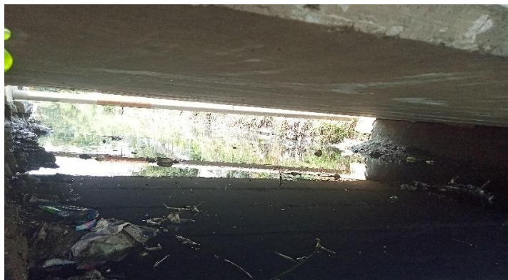
KONDISI BANGUNAN BAWAH
