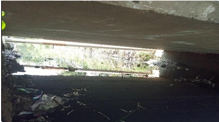
KONDISI BANGUNAN BAWAH
