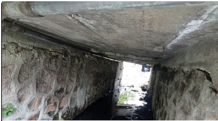
KONDISI BANGUNAN BAWAH
