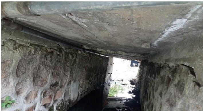
KONDISI BANGUNAN BAWAH
