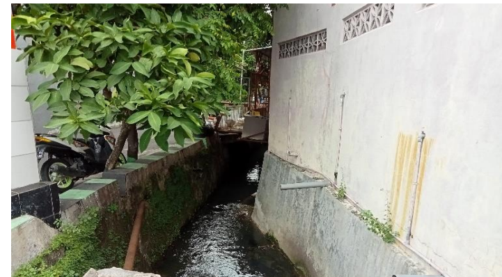
KONDISI ALIRA SUNGAI
