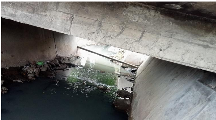
KONDISI BANGUNAN BAWAH
