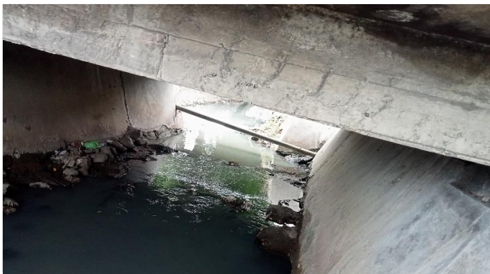
KONDISI BANGUNAN BAWAH
