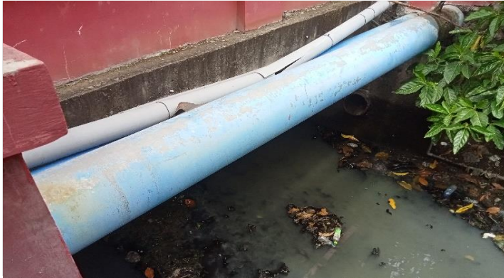
KONDISI BANGUNAN BAWAH
