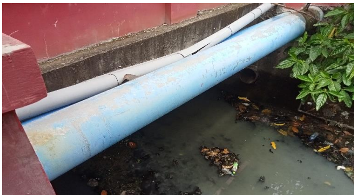
KONDISI BANGUNAN BAWAH
