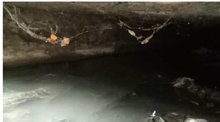
KONDISI BANGUNAN BAWAH
