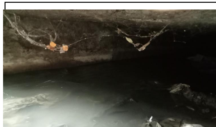
KONDISI BANGUNAN BAWAH
