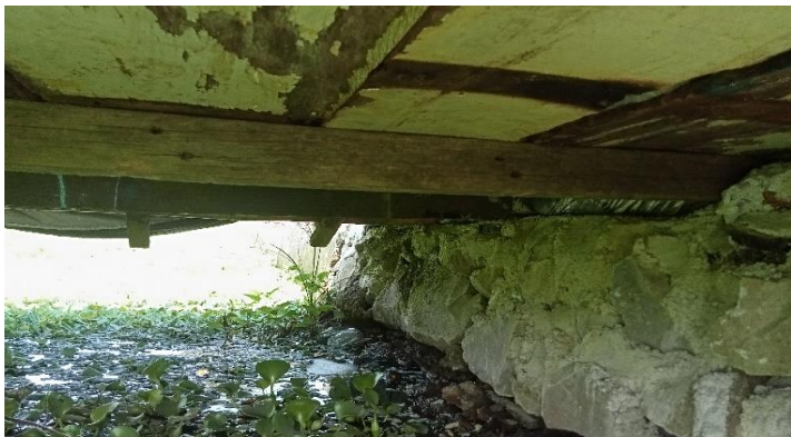
KONDISI BANGUNAN BAWAH
