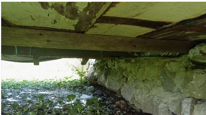
KONDISI BANGUNAN BAWAH
