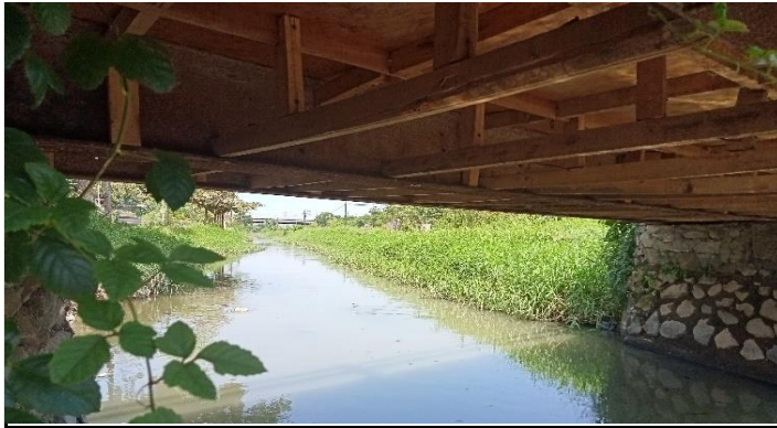
KONDISI BANGUNAN BAWAH
