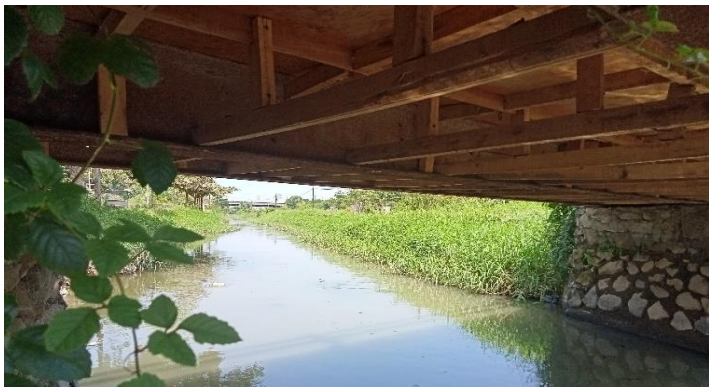
KONDISI BANGUNAN BAWAH
