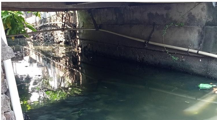
KONDISI BANGUNAN BAWAH
