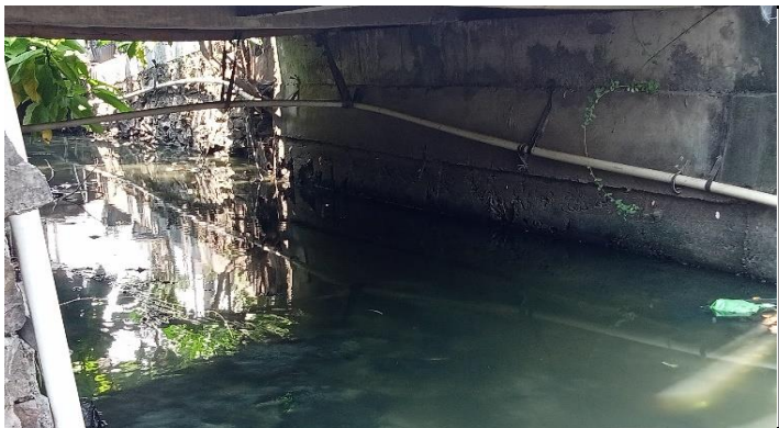
KONDISI BANGUNAN BAWAH
