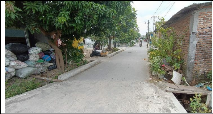
KONDISI JALAN PENDEKAT JEMBATAN
