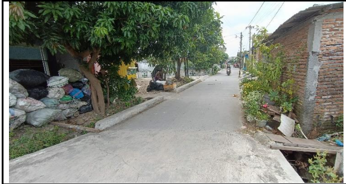
KONDISI JALAN PENDEKAT JEMBATAN
