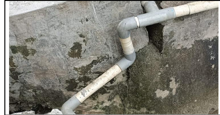
KONDISI PELAT JEMBATAN
