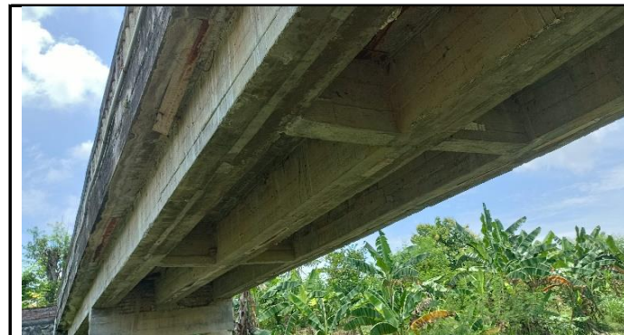
KONDISI GELAGAR JEMBATAN
