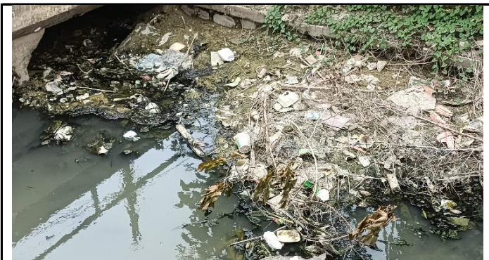
DEBRIS ATAU SAMPAH PADA ALIRAN SUNGAI YANG MAMPU MENYEBABKAN BANJIR
