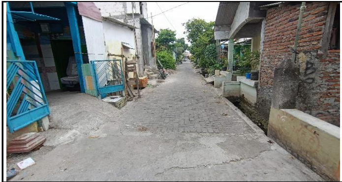
LAPISAN PERMUKAAN LANTAI BERLUBANG
