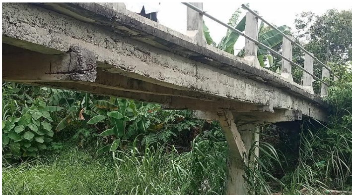
KONDISI BANGUNAN BAWAH
