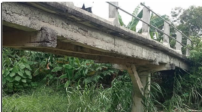
KONDISI BANGUNAN BAWAH
