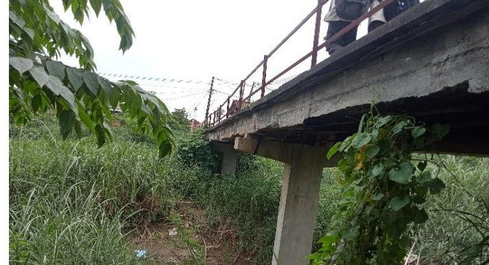
KONDISI BANGUNAN BAWAH
