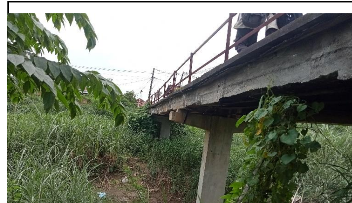
KONDISI BANGUNAN BAWAH
