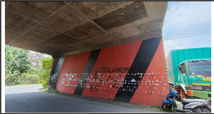
KONDISI PELAT JEMBATAN
