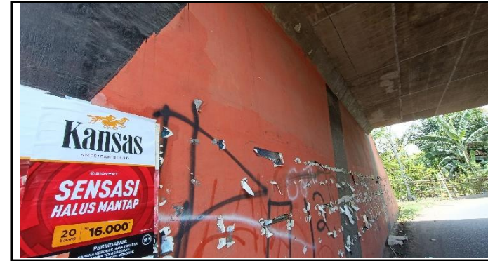
KONDISI KEPALA JEMBATAN
