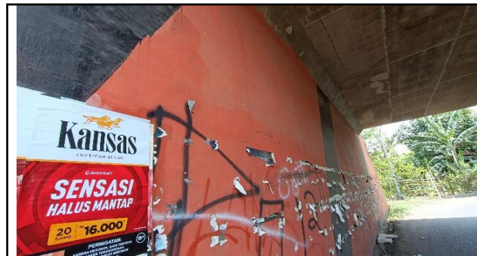
KONDISI KEPALA JEMBATAN
