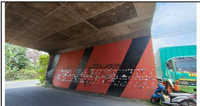
KONDISI PELAT JEMBATAN
