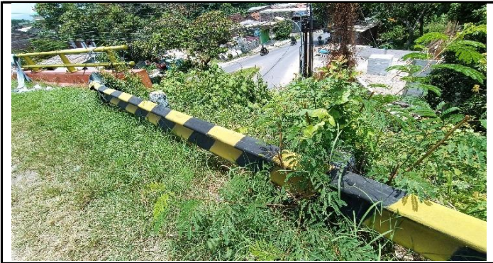
KONDISI PENGAMAN LALU LINTAS (GUARD RAIL)
