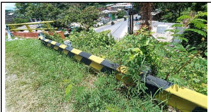
KONDISI PENGAMAN LALU LINTAS (GUARD RAIL)
