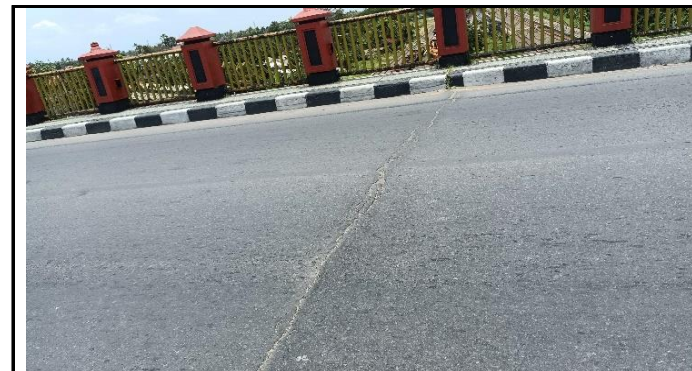
RETAK SAMBUNGAN SIAR MUAI PADA ASPAL
