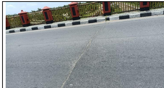
RETAK SAMBUNGAN SIAR MUAI PADA ASPAL
