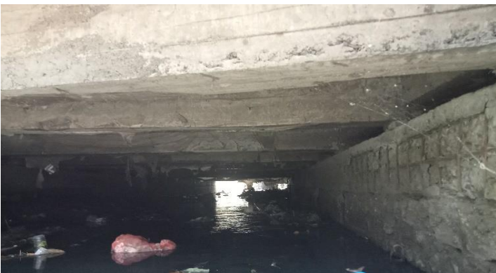
KONDISI BANGUNAN BAWAH
