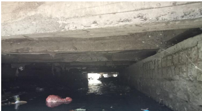
KONDISI BANGUNAN BAWAH
