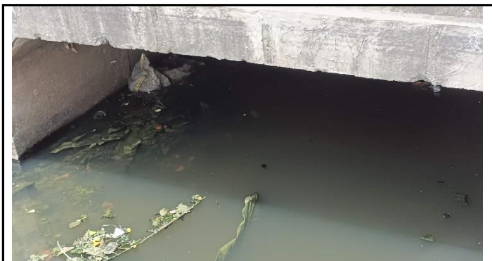
KONDISI BANGUNAN BAWAH
