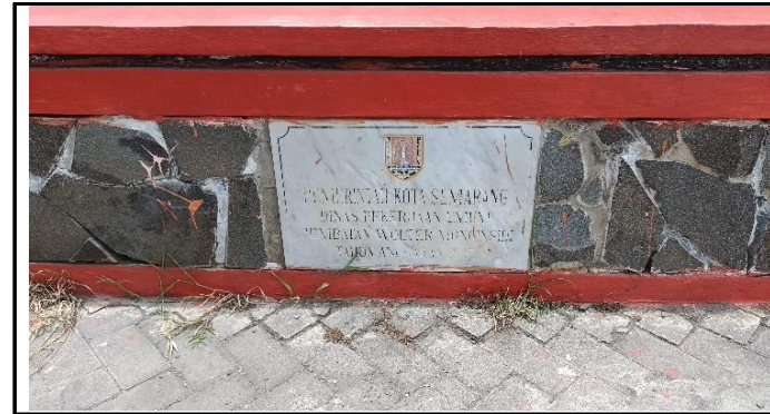
PAPAN PENANDA JEMBATAN
