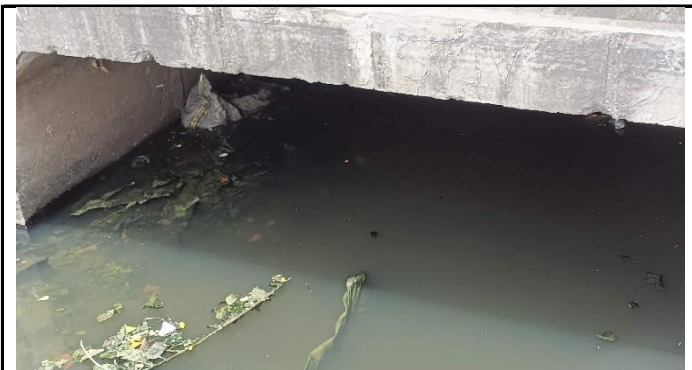
KONDISI BANGUNAN BAWAH
