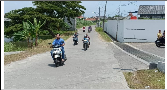
KONDISI JALAN PENDEKAT
