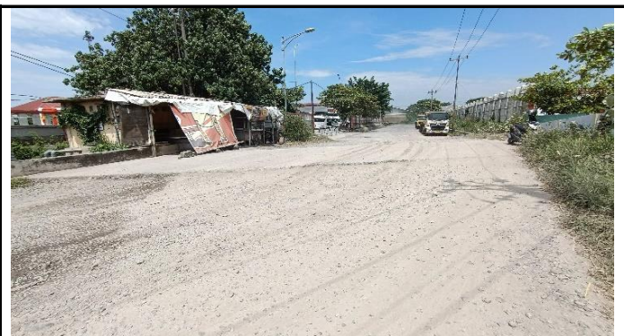
KERUSAKAN PADA JALAN PENDEKAT
