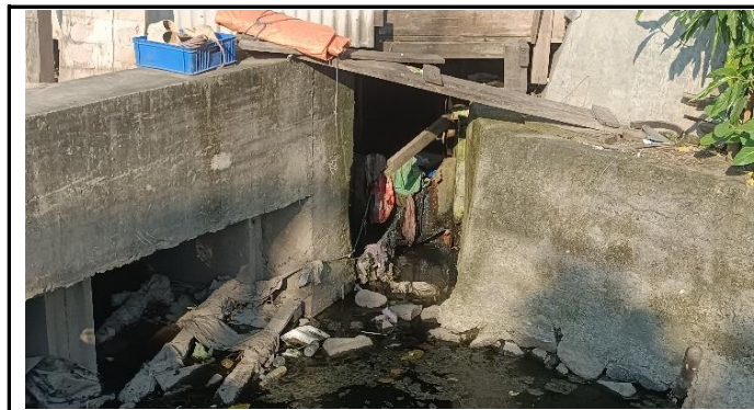
SANDARAN MEMBUTUHKAN PENGECATAN ULANG
