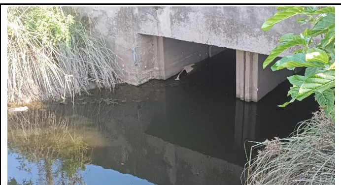
KONDISI BANGUNAN BAWAH
