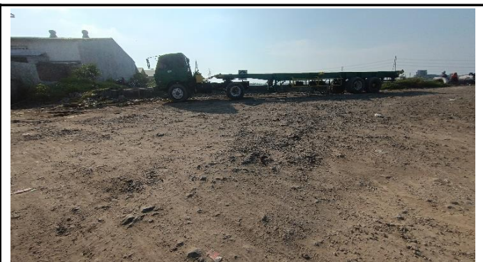
KERUSAKAN PADA LAPISAN PERMUKAAN LANTAI
