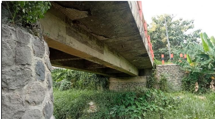
KONDISI BANGUNAN BAWAH
