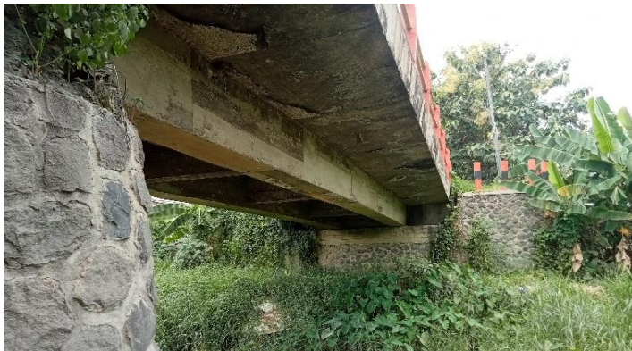
KONDISI BANGUNAN BAWAH
