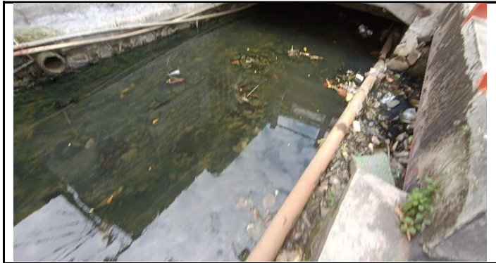
PENDANGKALAN SEDIMEN PADA ALIRAN SUNGAI
